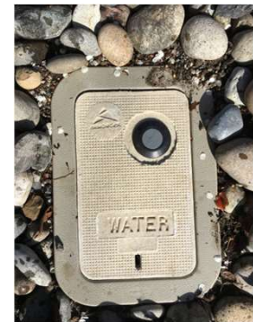
AMI Radio on Meter Box Lid
