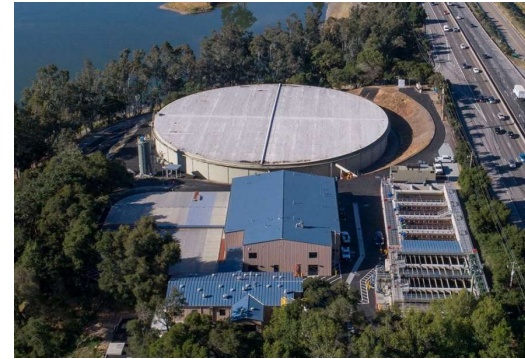
SJW Montevina WTP
